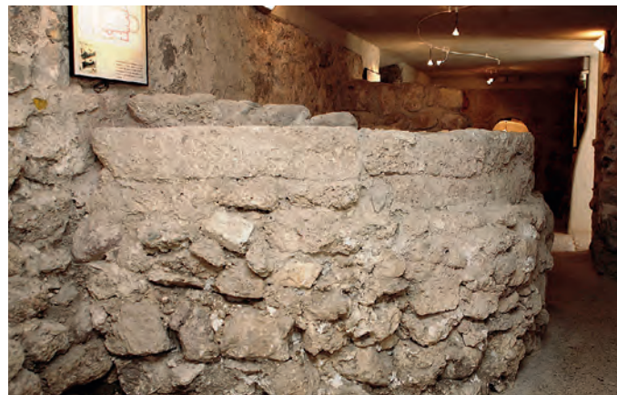
Resti di abside laterale di XII-XIII secolo.
